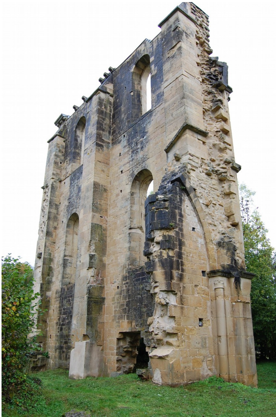
2- Mur ouest du bras nord du transept, abbatale de Cherlieu (Haute-Saône).
