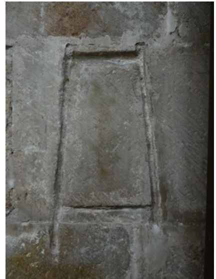
1- Gabarit de tuile gravé sur le mur de l'église Notre-Dame-des-Paneaux à Cluny, sans date. Cette église, indépendante de l'abbaye, conservait les gabarits en usage à Cluny dans les différents domaines de production. Photo Cyril Lacheze.
